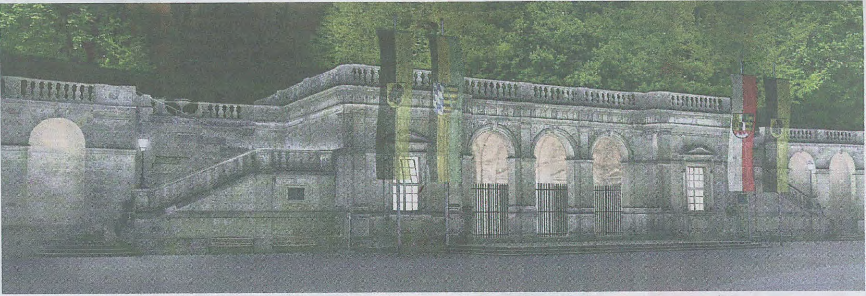
Die Sanierung ist weitestgehend abgeschlossen, jetzt sollen die Arkaden auch bei Dunkelheit ins rechte Licht gerückt werden.
